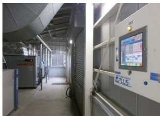
インバータ付コンプレッサーと運転台数制御装置の組み合わせによる省エネルギー活動 (しなの富士通)
