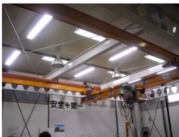
プレス棟： 水銀灯からHf蛍光灯に変更と 水銀灯の消灯による省エネ
