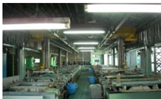
LED照明灯への切替 千曲通信工業
