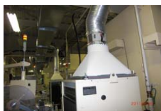
排熱ダクトへの断熱塗料塗布による冷房負荷低減
